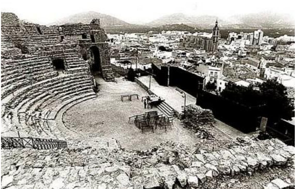
Fig.6 Teatro antes de la intervención de Portaceli y Grassi
